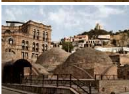
Alte Zeugen: Dreifaltigkeitskirche Gdzeghi (oben) und die Kuppeldächer von Badehäusern in Tiflis
