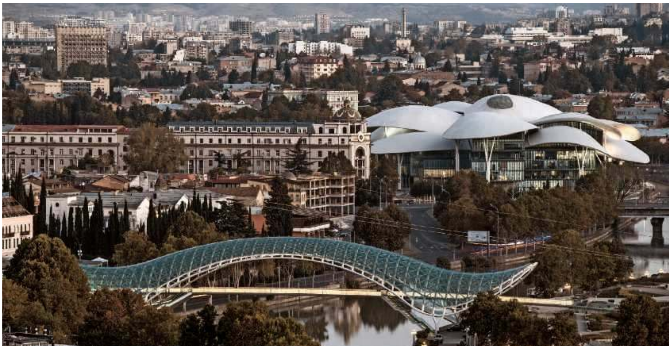
Moderne Blickfänge: Bauten wie die Friedensbrücke und das Haus der öffentlichen Verwaltung ragen aus dem Häusermeer von Tiflis hervor
